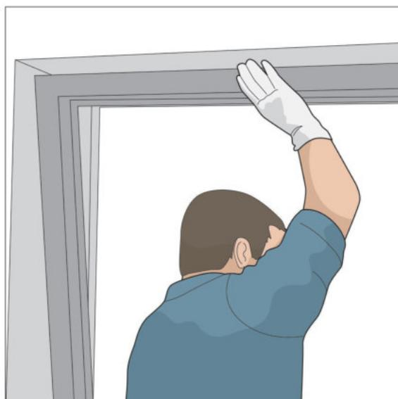
Richten Sie den Rahmen mit Hilfe der Wasserwaage aus (Abb. Rechts). Um Unebenheiten auszugleichen.
